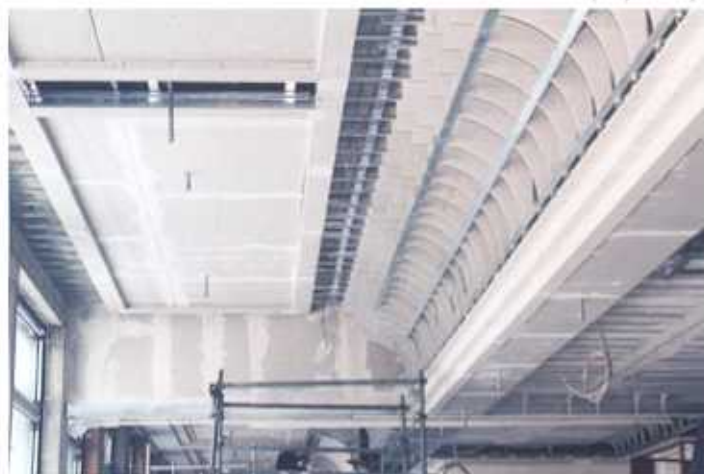
GF-Spanen. Alle Spanen wurden aus Gipsfaserplatten passgenau gefräst, um einen möglichst hohen Grad an passivem Brandschutz bei der Deckenmontage zu gewährleisten.
