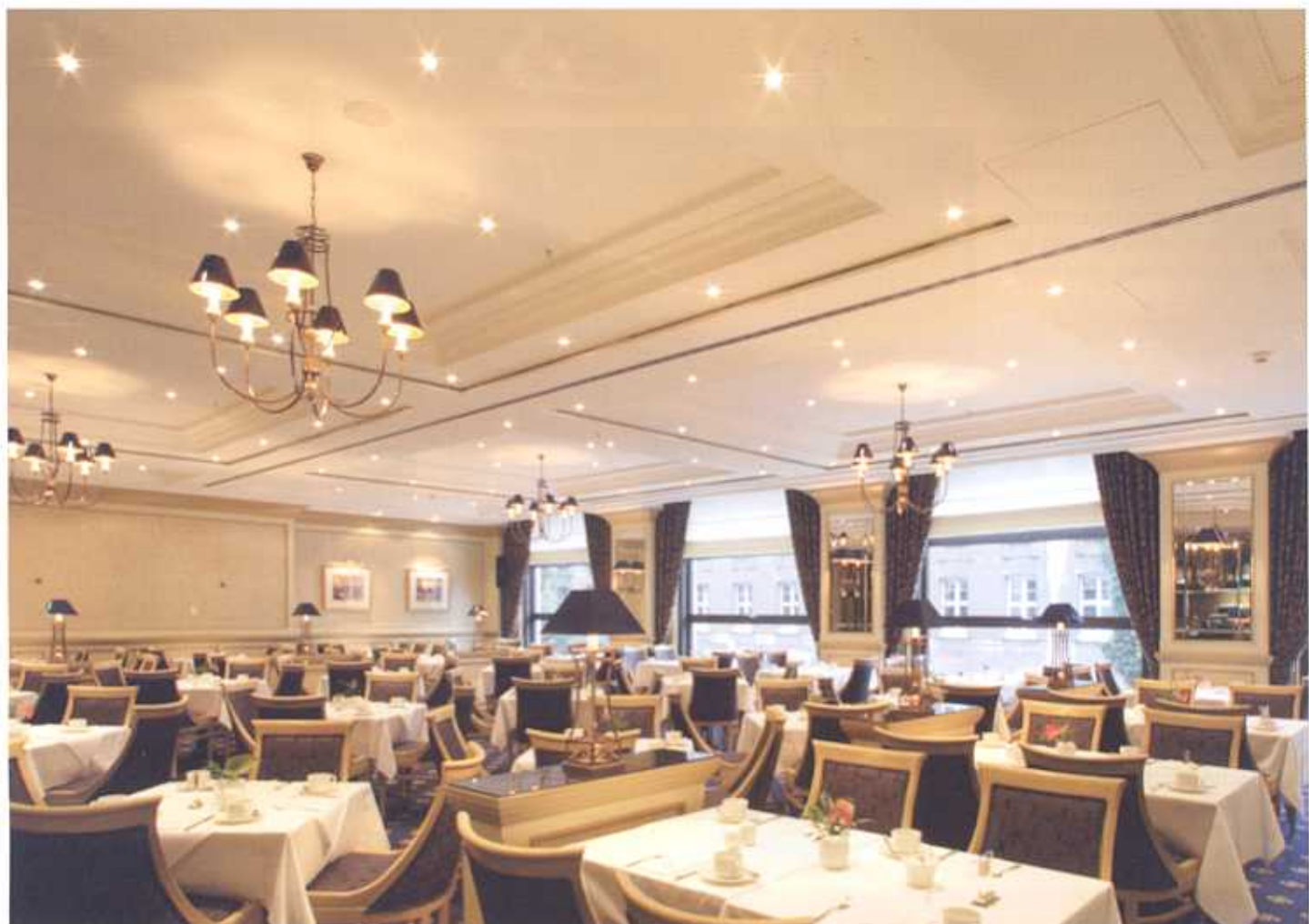
Stil-Form. Formteile spielen eine wesentliche Rolle bei der Gestaltung der Decken in allen Bereichen des Maritim Hotels Berlin. Aus Gründen der Effizienz wurden wie hier im Restaurant oft mehrere Treppungen in einem vorgefertigten Formteil angeliefert.
