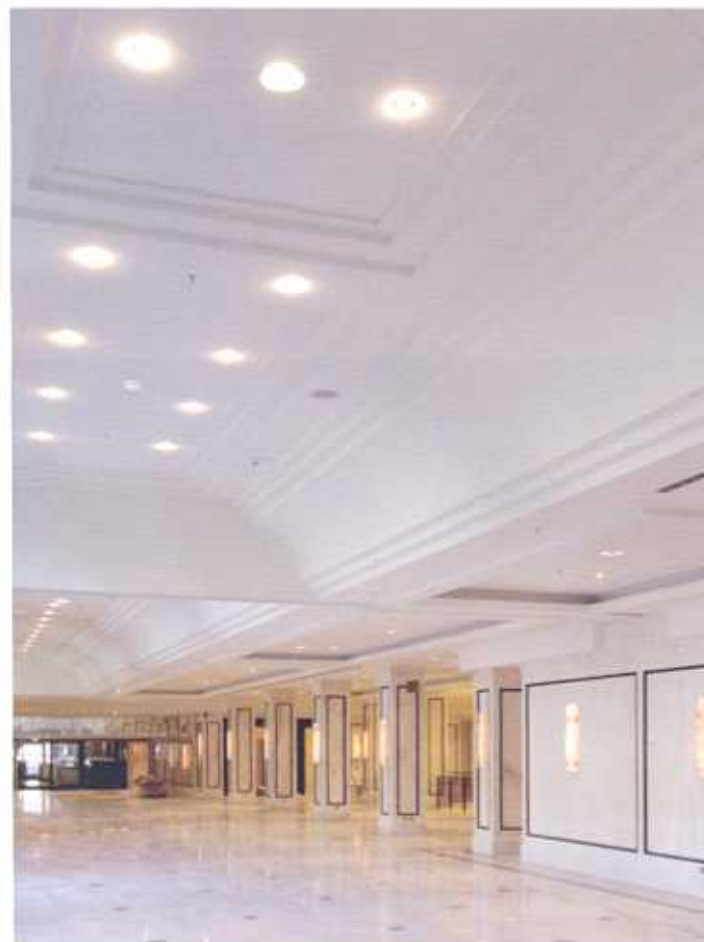
Weite Decken. Mehr als 10 000 m 2 Schmuckdecken wurden im Maritim Hotel Berlin eingebaut. Weit mehr als die Hälfte der Flächen wurden dabei mit vorgefertigten Formteilen bestückt.
